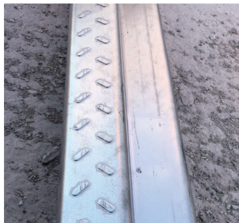
天端面はイボイボの滑り止め加工がされています。
