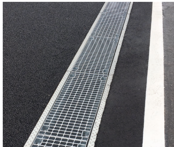
枠は角欠け防止用のZアングルになっています。
